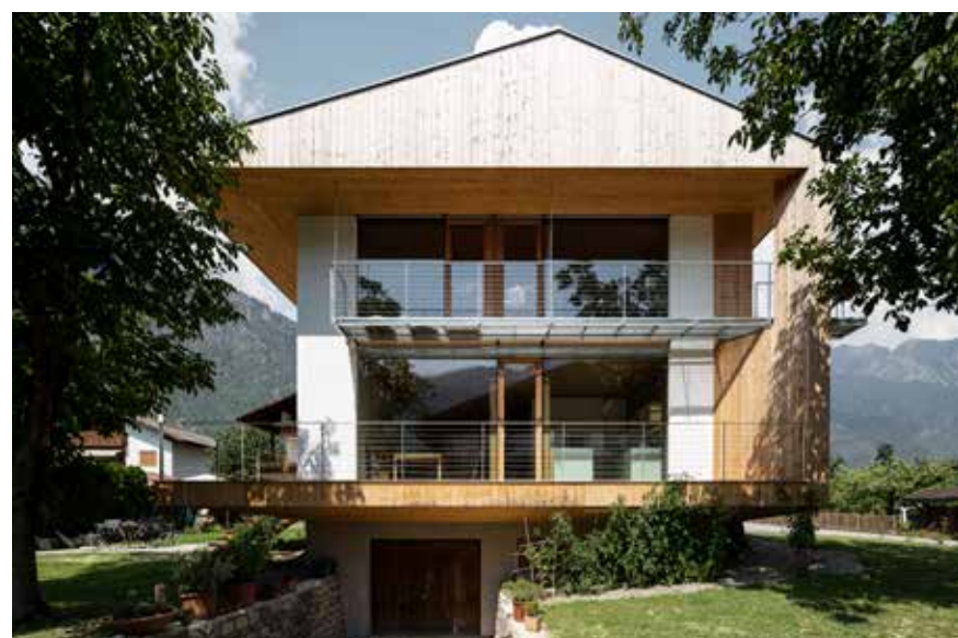
Selbstversorger: Die Südfassade des 115 Quadratmeter großen Strohhauses ist komplett verglast. Dies garantiert einen hohen solaren Wärmeeintrag. Im Sommer schützen Balkon und Dachüberstand das Gebäude vor Überhitzung.
